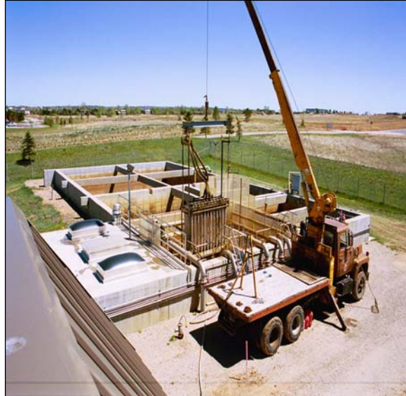
Figura 13, Colocación de membranas en un reactor biológico existente
