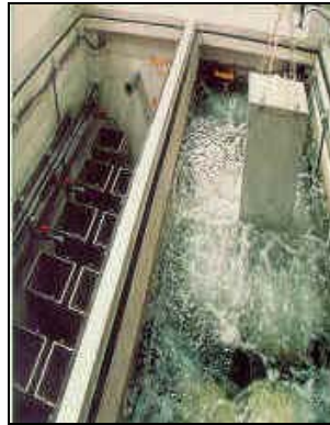
Figura 15, Extracción de un cassette KUBOTA
