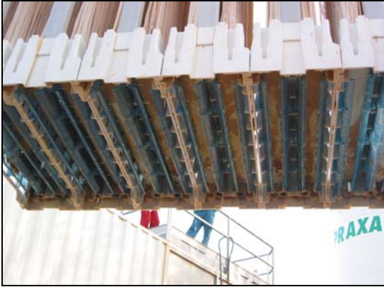
Figura 11, Vista inferior de un módulo de membranas con los canales plásticos en color azul para la difusión de aire
